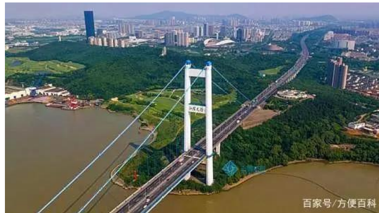
江阴长江大桥—— 我国首座跨径超 千米的特大型钢 箱梁悬索桥梁
