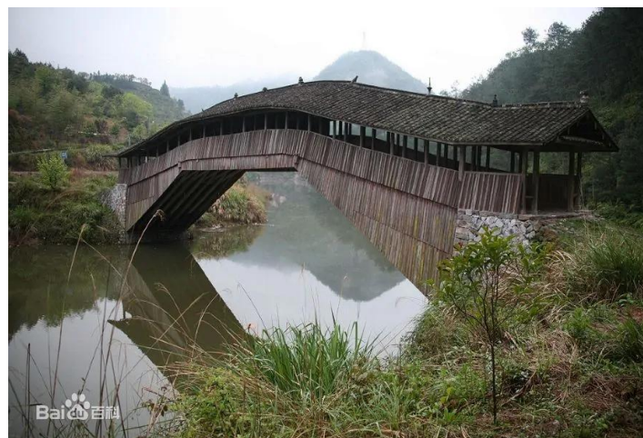
廊桥（泰顺廊桥）
